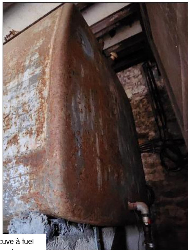
Cuve de 20 m3 à sécuriser car récupère des eaux potentiellement souillées
